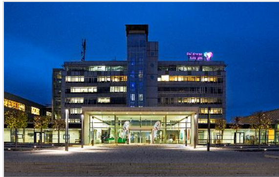
Unternehmenszentrale der TEAG Thüringer Energie AG in Erfurt
