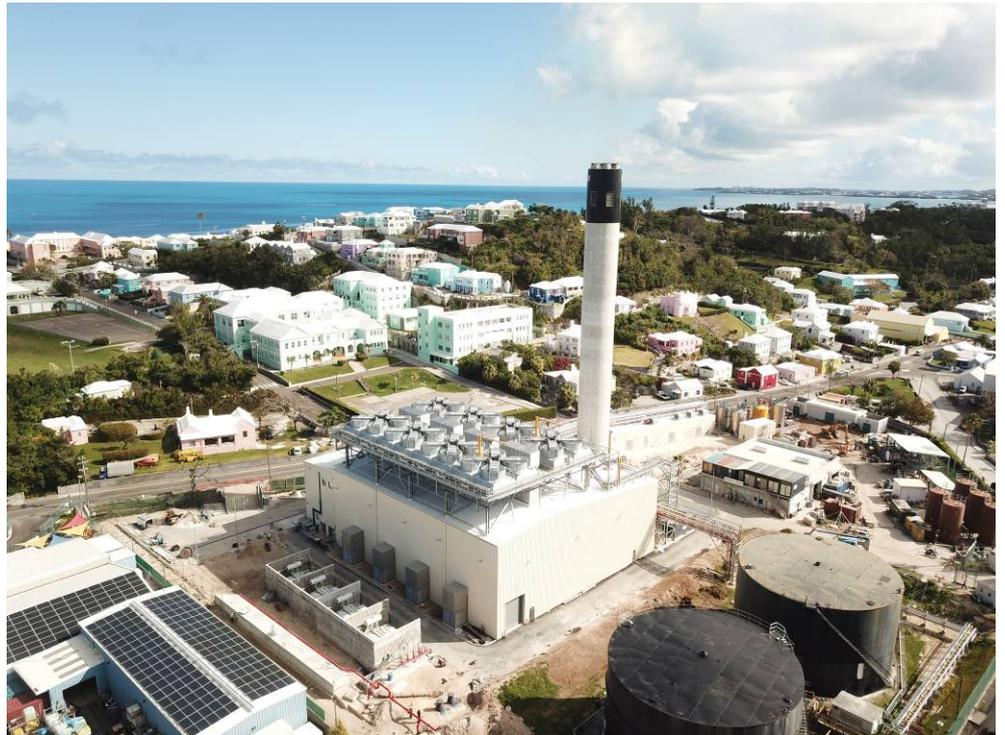
*Vier MAN 14V51/60 Dual-Fuel-Motoren erweitern den Kraftwerkskomplex in Pembroke auf Bermuda um weitere 56 MW.*
