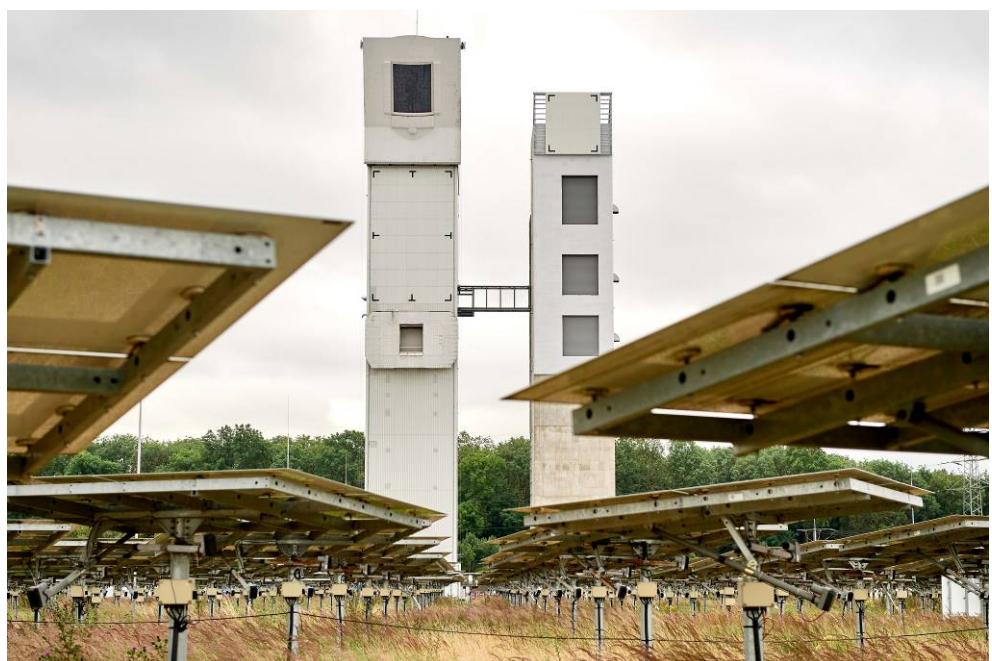
*Das Deutsche Zentrum für Luft- und Raumfahrt hat MAN Energy Solutions mit dem Bau eines Flüssigsalzkreislaufs für seine Solarforschungsanlage (im Bild) in Jülich beauftragt.*
