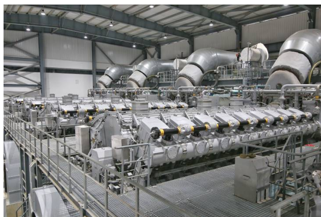
Das Kraftwerk in Kambodscha besteht aus elf MAN 18V51/60DF Motoren (Bildquelle: Electricité du Cambodge)
