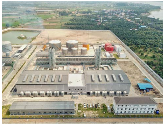
MAN Energy Solutions hat ein 200-MW-Kraftwerk in der Nähe der kambodschanischen Hauptstadt Phnom Penh in Betrieb genommen. (Bildquelle: Electricité du Cambodge)
