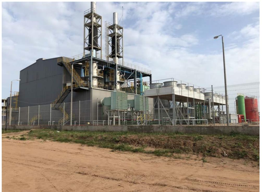
*In Brikama, Gambia, hat MAN Energy Solutions ein Kraftwerk bestehend aus zwei 9L51/60-Motoren gebaut und in Betrieb genommen.*
