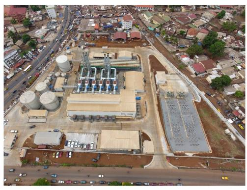
À Conakry, en Guinée, MAN Energy Solutions a installé moteurs MAN 18V32/40 dans une centrale électrique qui fournira 53 MW d'énergie électrique à la ville.
