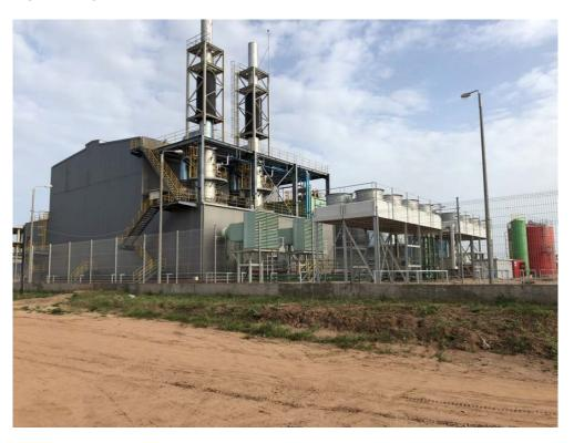
À Brikama, en Gambie, MAN Energy Solutions a construit et mis en service une centrale électrique composée de 2 moteurs MAN 9L51/60.
