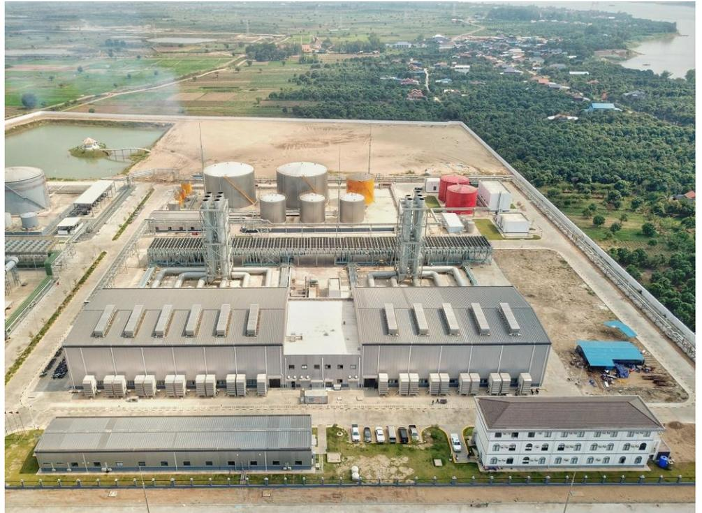
*MAN Energy Solutions hat im April 2021 ein 200-MW-Kraftwerk nahe der kambodschanischen Hauptstadt Phnom Penh in Betrieb genommen. Die Anlage besteht aus elf MAN 18V51/60DF-Motoren (Bild mit freundlicher Genehmigung von Electricité du Cambodge)*
