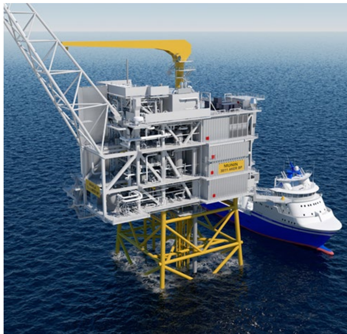
Die Munin-Gasförderplattform wird von Land aus ferngesteuert (Bild ©Aibel)
