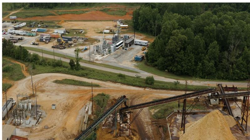
*In Alabama, USA, produziert die Vergasungs- und Fischer-Tropsch-Anlage von Cetna Energy aus Sägewerksrückständen Synthesegas – die Basis für die Erzeugung von erneuerbarem Erdgas. ©Cetna Energy*
