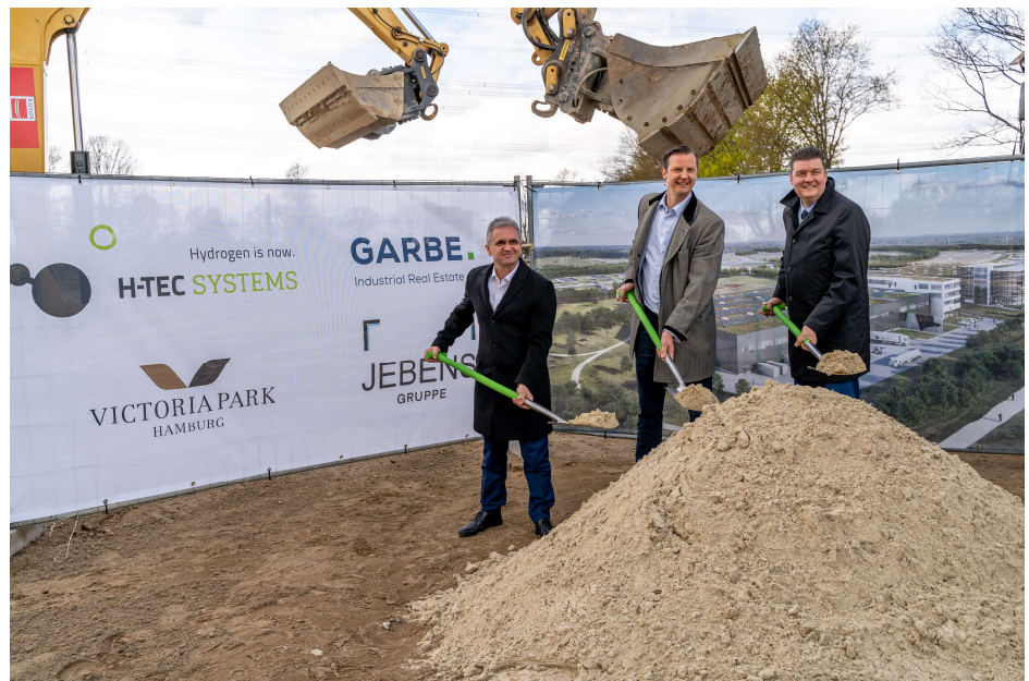
Spatenstich-Zeremonie markiert den Baubeginn für das H-TEC SYSTEMS Stack Manufacturing & Development Center; Im Bild (von links): Dr. Uwe Lauber, CEO MAN Energy Solutions; Robin von Plettenberg, CEO/CSO H-TEC SYSTEMS; Dr. Andreas Dressel, Finanzsenator der Freien Hansestadt Hamburg
