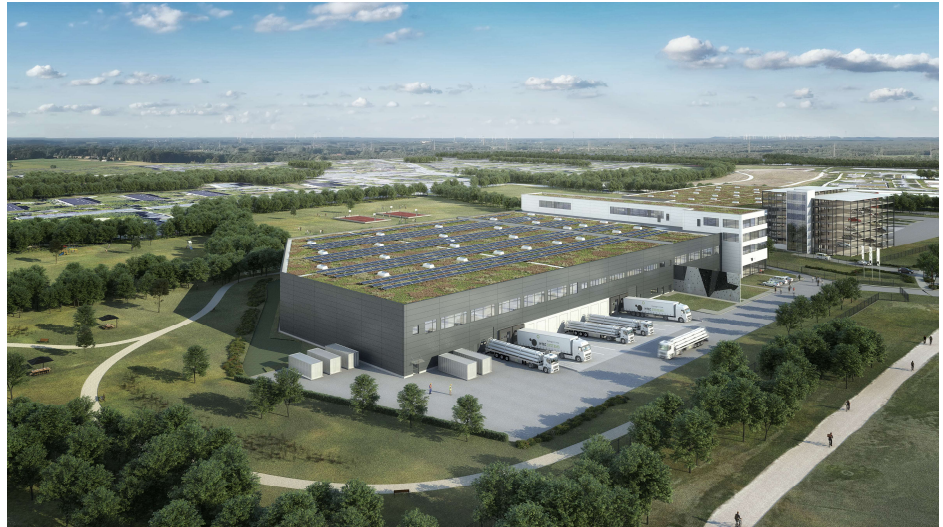
H-TEC SYSTEMS errichtet eine hochmoderne Fabrik zur industriellen Serienfertigung von PEM-Elektrolyse-Stacks
